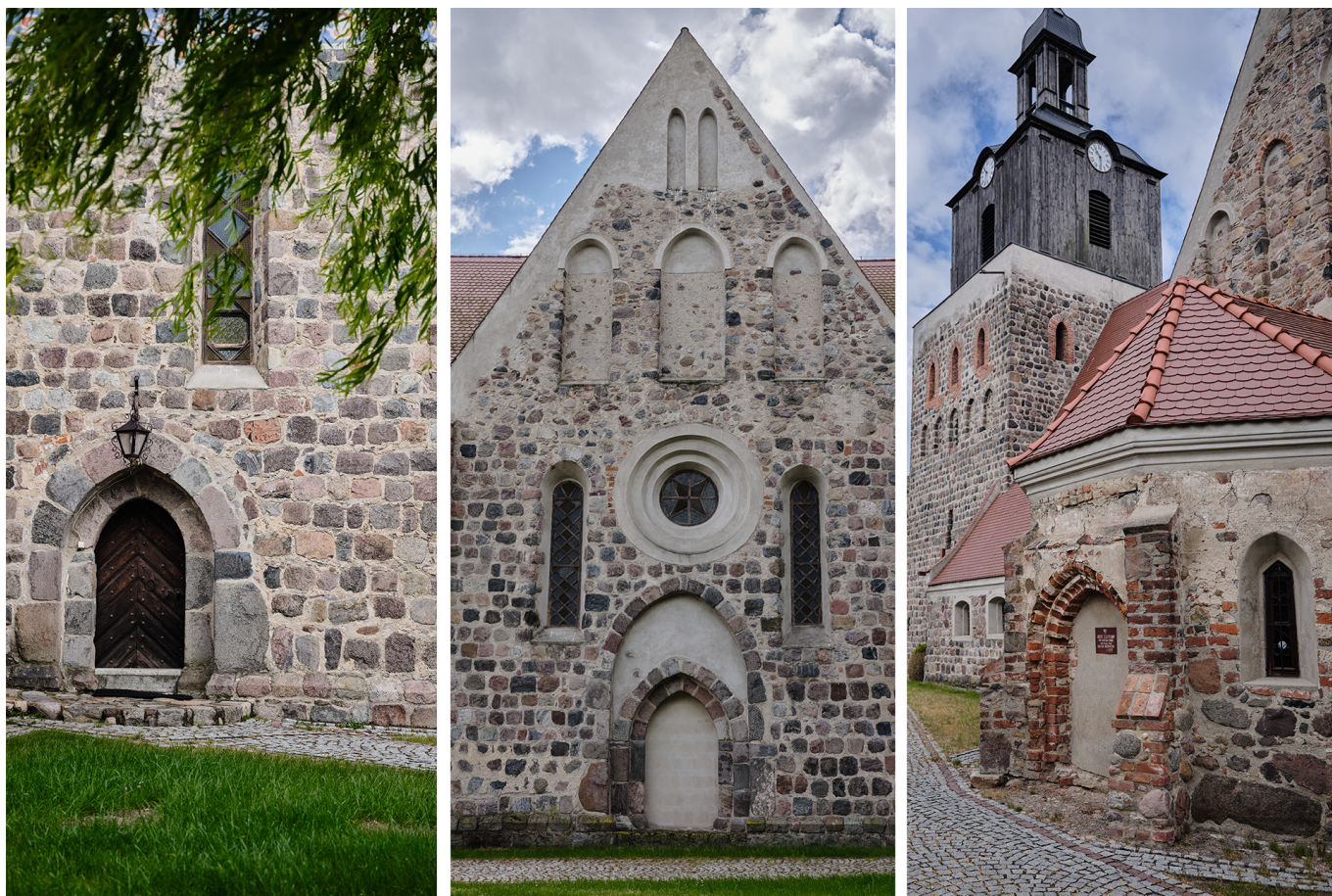
Elewacja południowa, elewacja północna, zakrystia / fot. Aleksander Pukalski / Moryń 2025.
